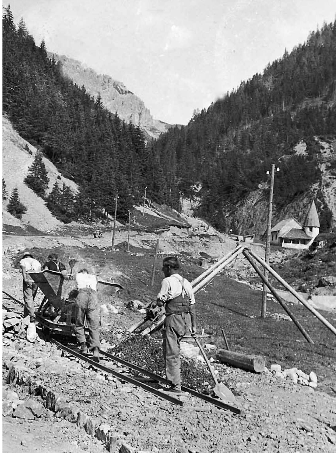
**Abb.21** Nach dem Zweiten Weltkrieg wird die Strasse von Triesenberg nach Malbun ausgebaut.
